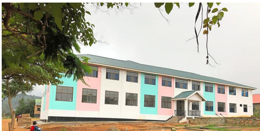
Der Neubau der St. Charles Schule in Tansania. Foto: Pier
